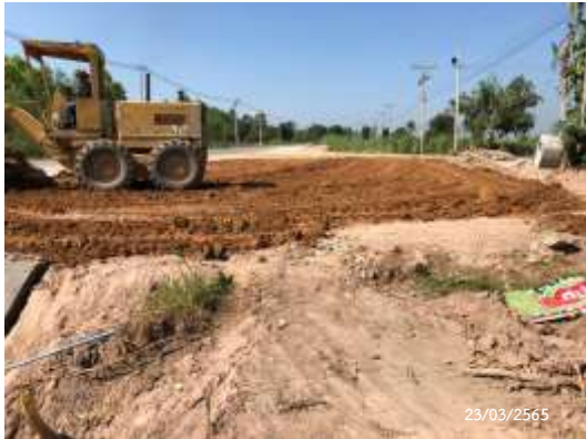
ภาพที่ 91 การซ่อมแซมเส้นทางลำเลียงของรถบรรทุก
