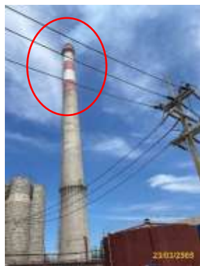
ภาพที่ 94 ติดตั้งไฟสัญญาณ และทาสี บริเวณปล่องระบาย
