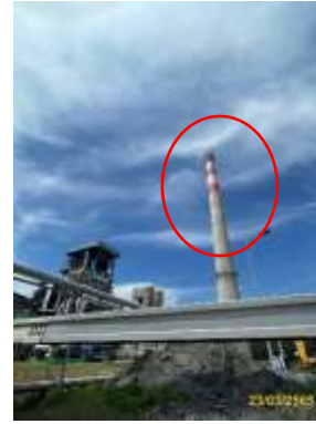
ภาพที่ 94 ติดตั้งไฟสัญญาณ และทาสี บริเวณปล่องระบาย
